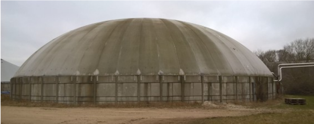
Billede 2. Efterafgasningstank med svovlrensning. Foto: Niels Østergaard.
